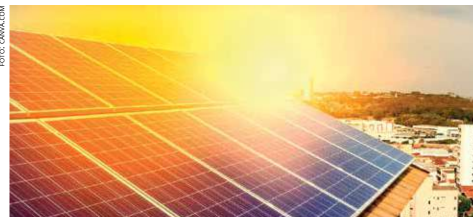
Geração de energia solar por meio de painéis fotovoltaicos
