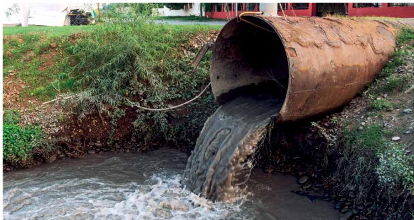
O rio sofre por causa de despejo de esgotos e resíduos orgânicos sem tratamento
